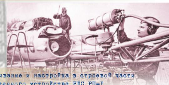
Обслуживание и настройка в строевой части ВВС антенного устройства РЛС РП-І «Изумруд» на самолете МиГ-І9Р
