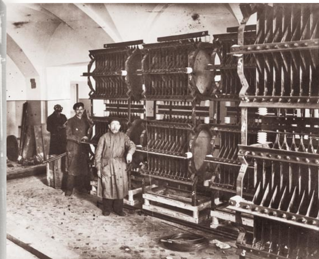
Сборка воздушных конденсаторов для «Нового Коминтерна»
