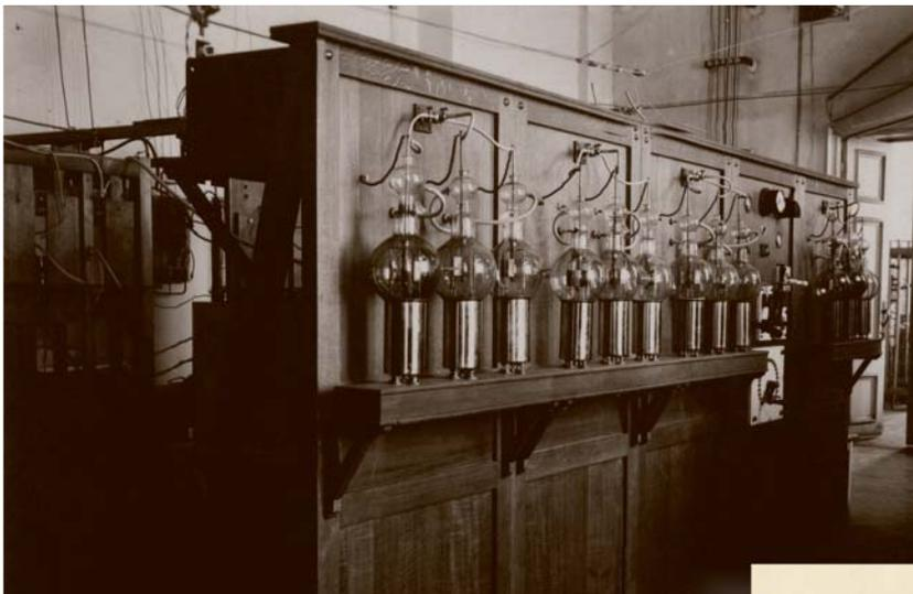
Передатчик первой радиовещательной станции им. Коминтерна
