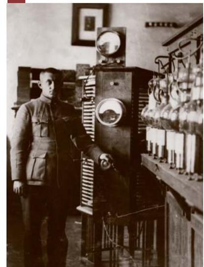
Эксплуатация Центральной радиотелефонной станции в Москве позволила установить потребность в мощных радиолампах системы М.А. Бонч-Бруевича с водяным охлаждением.
