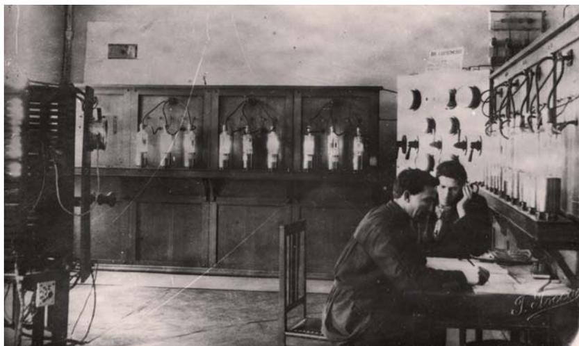
Станция им. Коминтерна с новыми лампами мощностью 2 кВт. 1924 г.
