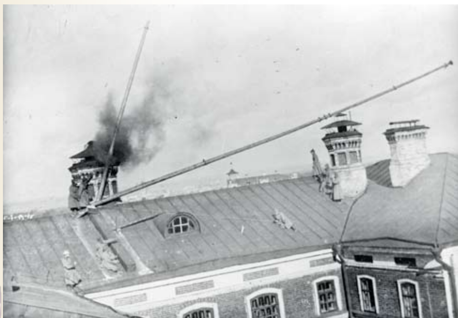
Подъем мачты радиоантенны на крыше здания НРЛ
