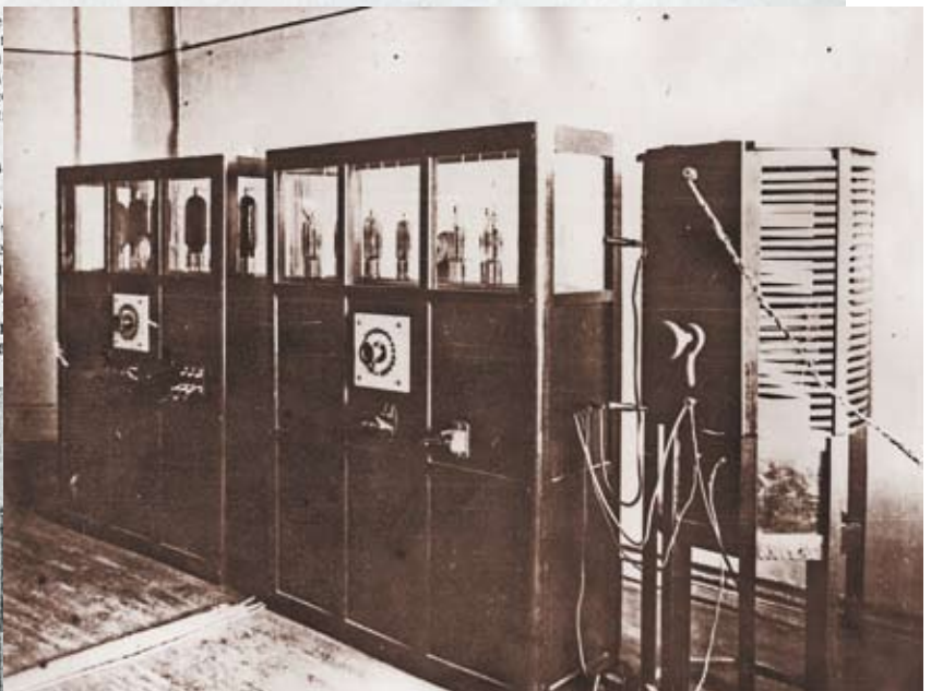
Первый экземпляр радиотелефонного передатчика «Малый Коминтерн» мощностью 1,2 кВт конструкции С.И. Шапошникова. 1924 год
