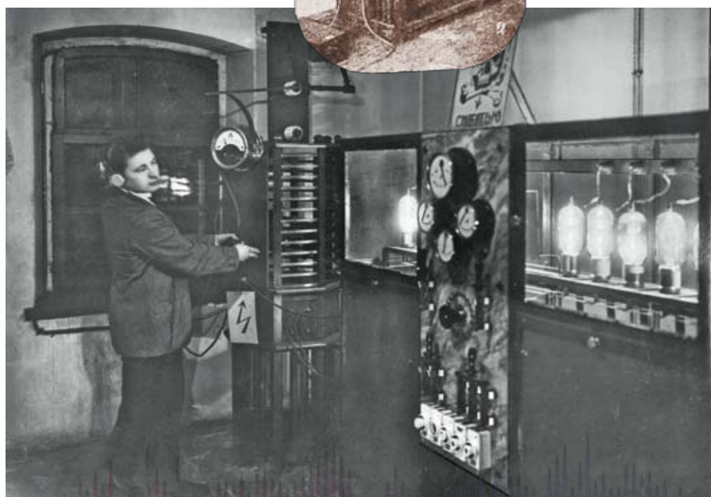
Первый передатчик радиостанции «Малый Коминтерн» имени В.М. Лецинского (Нижгубисполкома)
