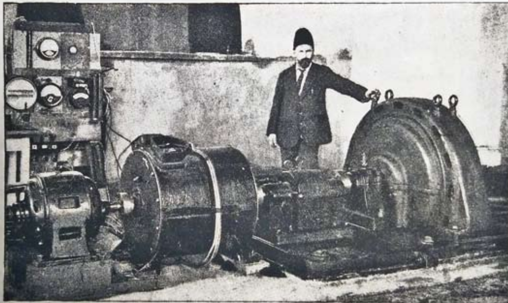
50-квт. машина высокой частоты В. П. Вологодина и ее автор. Эта машина устанавливается в Москве на Ходынской радиостанции.
