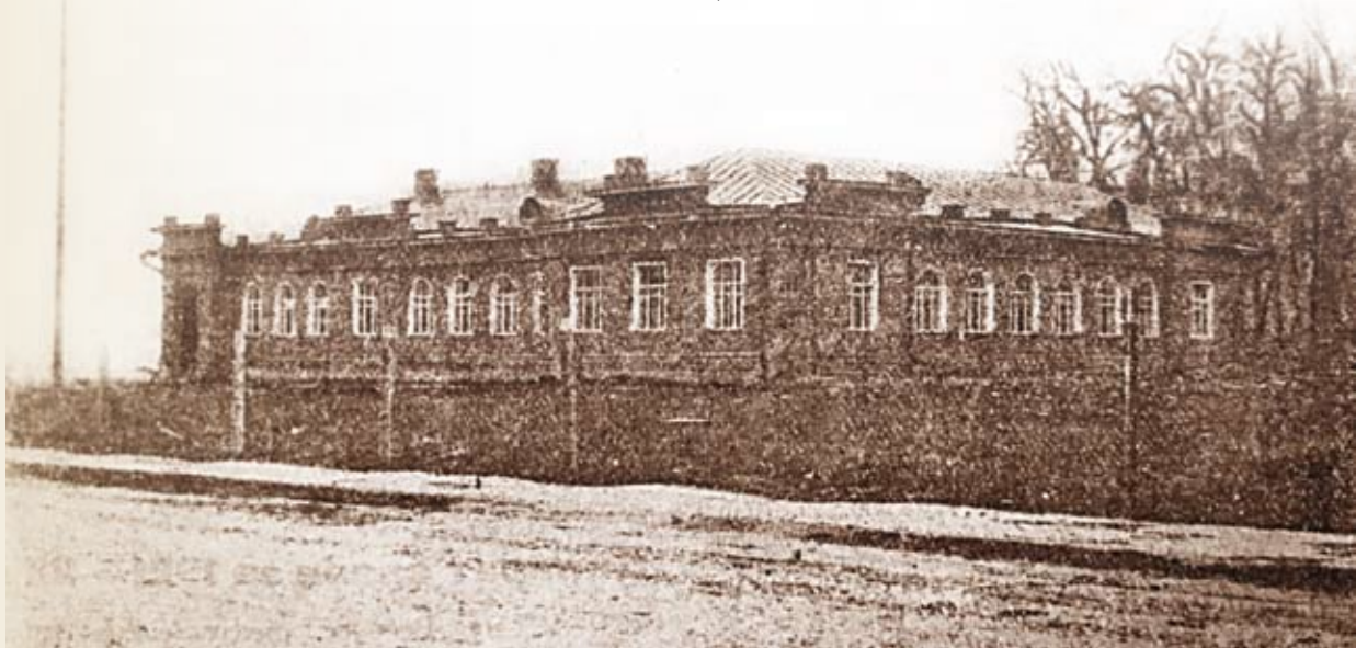
Здание Московской центральной радиотелефонной станции (Техника связи. 1923. № 4–5. С. 127)
